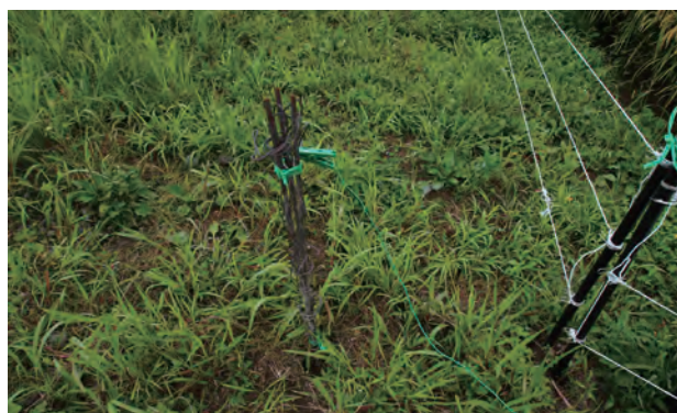
写真 40 /アース棒を束ねた上に打ち込まれていない アースは必要本数を払って打ち込むほど効果は高くなる
