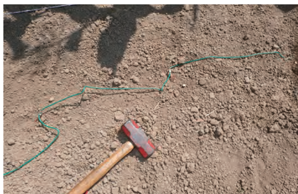
写真 43 /水はけのよい乾燥土壌では、アースの効果は落ち電圧が上がりにくい場合があるので注意が必要
