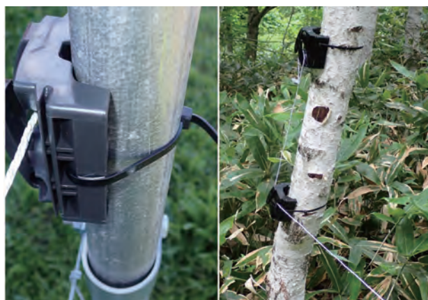
写真 80 / 立木や単管に結束バンドで固定できる碍子（TT 碍子）既存の木を痛めず対策が可能
