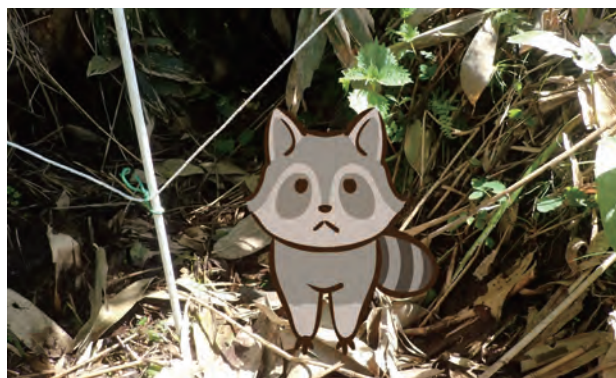
写真 60 / ポールを起伏に対して適切に打ち込まない場合、ワイヤーに触れずに侵入できる隙間が生じそこを狙われる恐れがある
