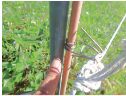
写真 73 / 補強で添えた金属杭がクリップに触れ漏電している
